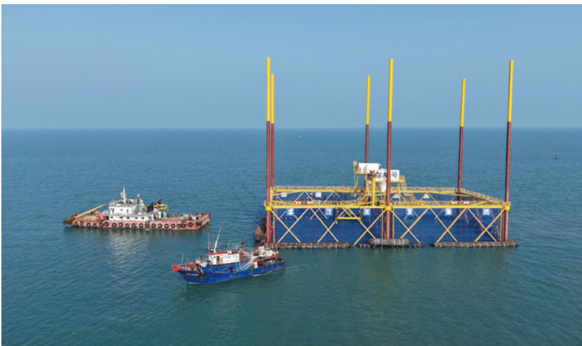
广东规模最大的座底式桁架智能养殖平台——“湛农1号”第二组网箱模块顺利下水。 刘冀城 摄
