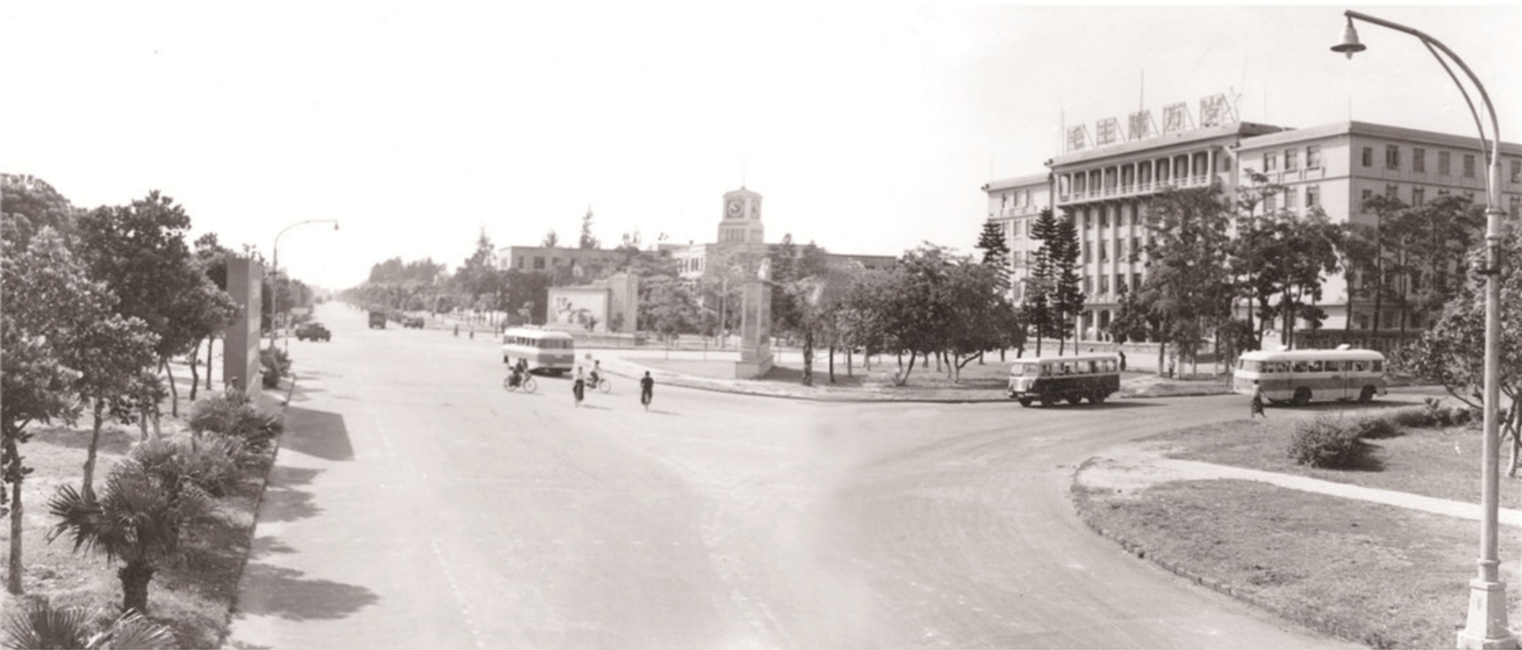
建于 1959 年市政府大楼（薛茂芬建筑师作品）。
