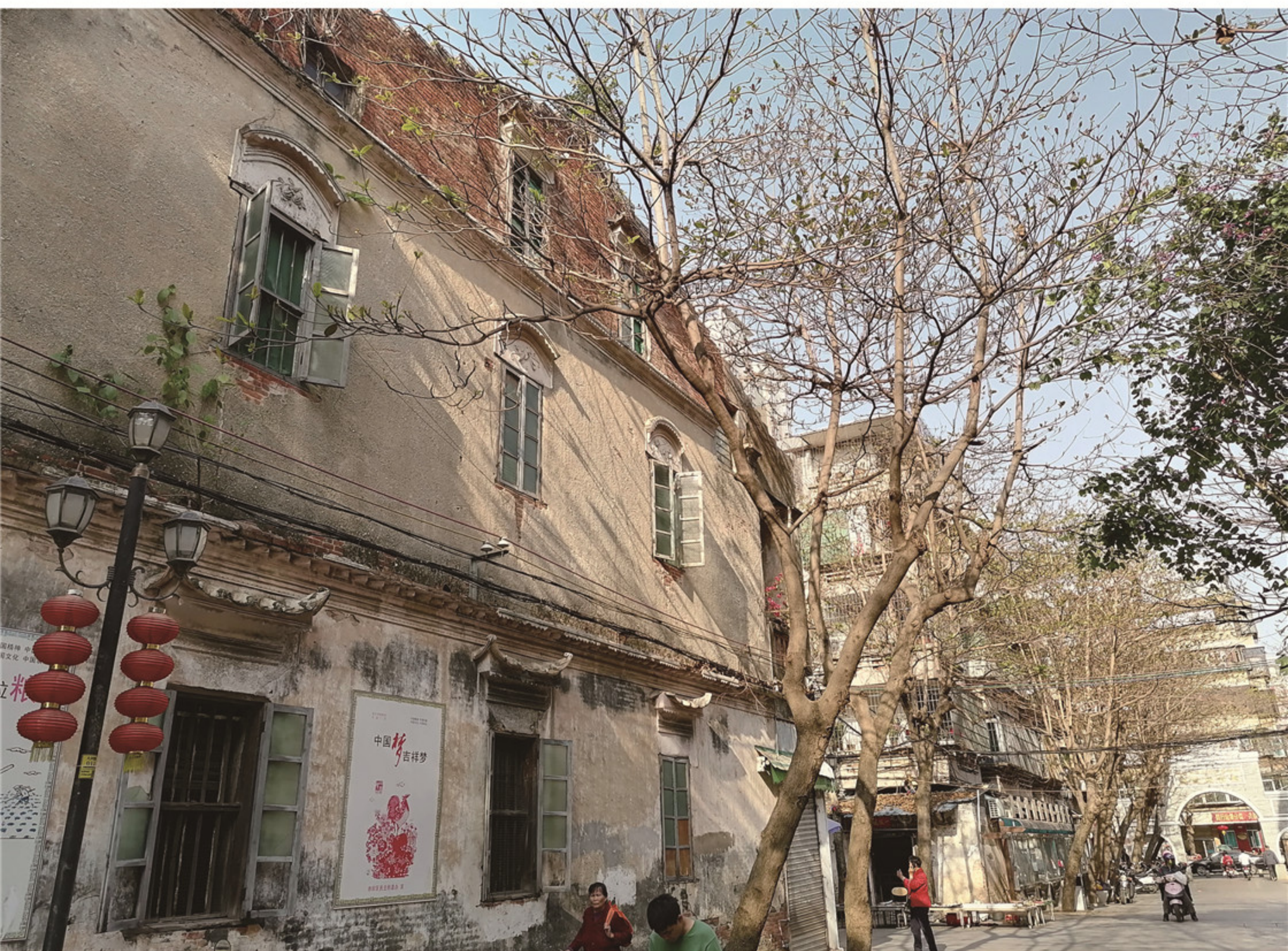
法国梧桐掩映的老街建筑。
