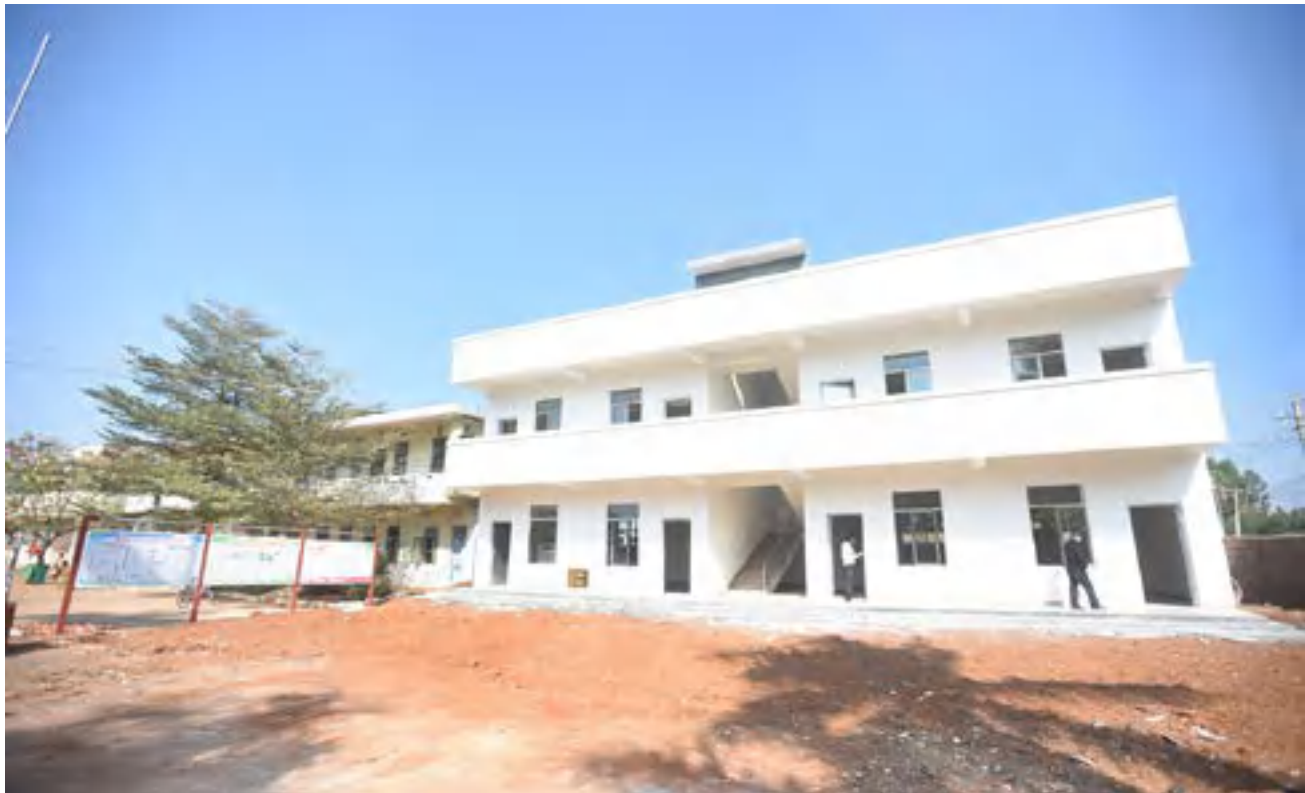
近日，由驻村扶贫工作队帮扶建设的雷州市英利镇迈炭村幼儿园主体工程完工。 刘冀城 摄
